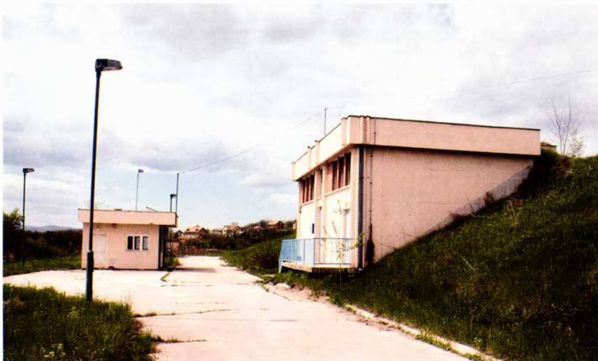
Љубић: Највећи резервоар у систему за снабдевање водом, зајемине 8.000 м 3
